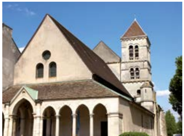
À l'automne 2019, débuteront à l'église Saint-Nicolas des travaux importants pour assurer la pérennité de ce joyau de notre patrimoine
