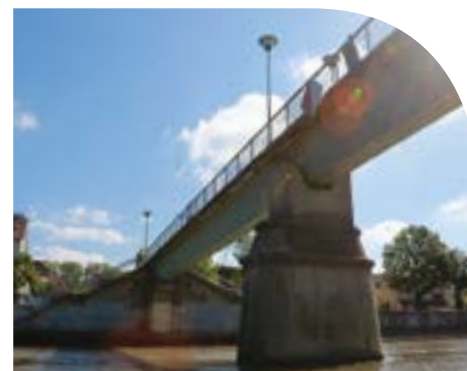
Mise en accessibilité de la passerelle de La Pie
