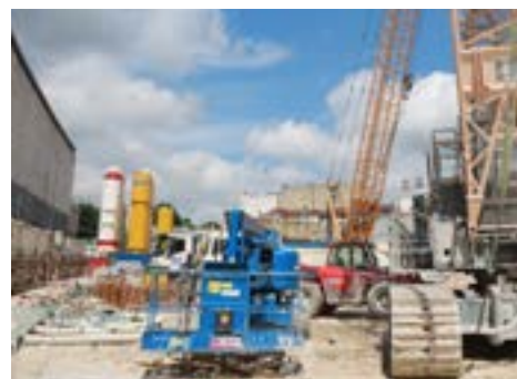
Le chantier de la future gare du Grand Paris Express sur le site de la gare Saint-Maur Créteil
