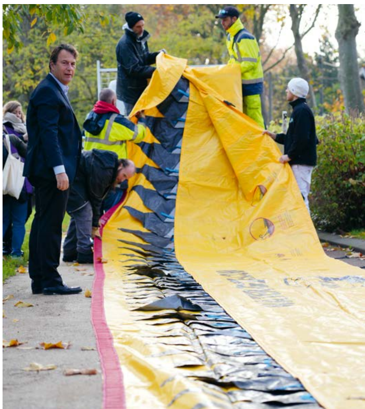
Déploiement des 800 mètres de digue mobile anti-crue.
