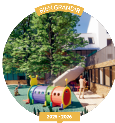
NOUVELLE CRÈCHE DIDEROT DE 40 PLACES
