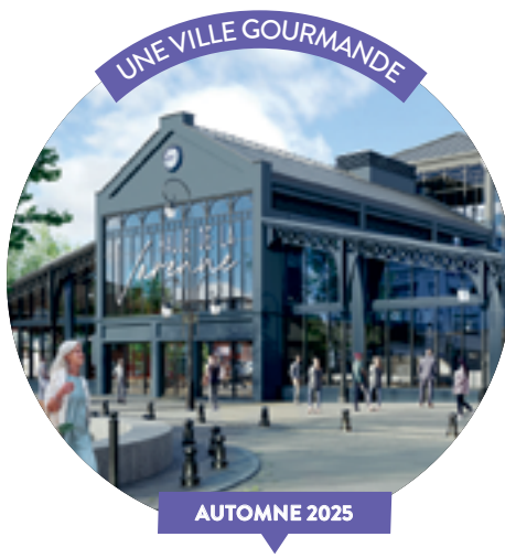
NOUVELLES HALLES DE MARCHÉS DE LA VARENNE ET D'ADAMVILLE
