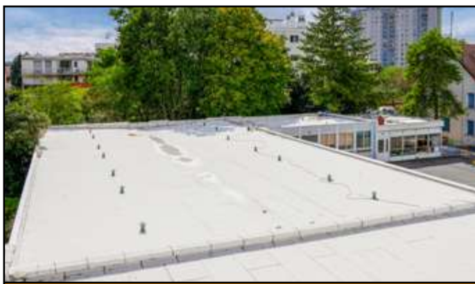
Toit du groupe scolaire Les Chalets
