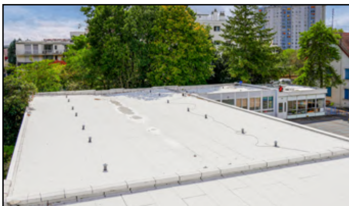
Toit du groupe scolaire Les Chalets
