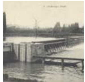
La construction du barrage sonne le glas des activités nautiques dans le quartier
