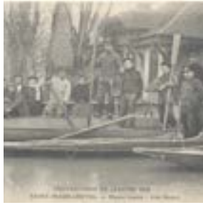
La maison Camus lors des mêmes inondations. Le quartier Schaken a été totalement submergé.
