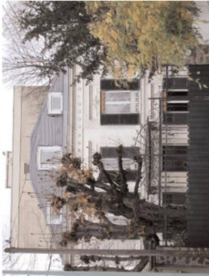
Ordonnement symétrique enrichi par un vocabulaire néo-classique. Façade constituée d'une maçonnerie ancienne, recouverte d'un enduit plâtre peint.
