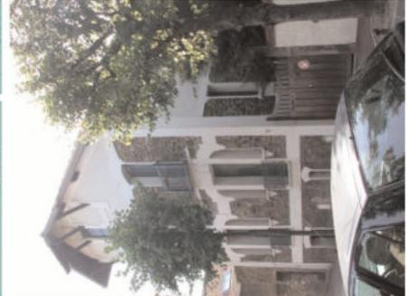
Maçonnerie de moellons de meulière apparents, modénature en enduit plâtre peint pour les linteaux et bandeaux. Les décorations des ouvertures du premier sont traitées en arc. Debord de toit et jambes de force.
