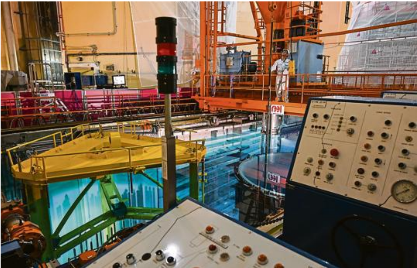
Le chantier de la centrale du Tricastin se prolongera jusqu'en 2023. Photo Philippe Desmazes/AFP
