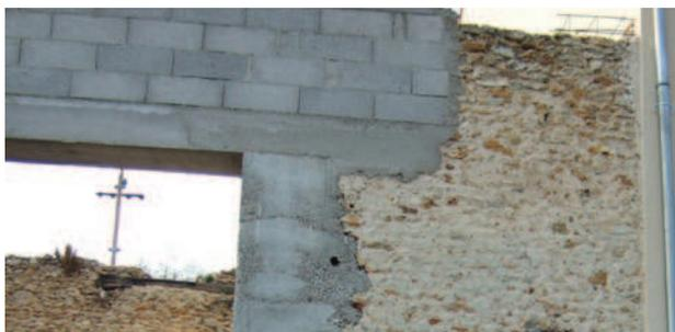
Les liaisons entre matériaux différents sont des sources possibles d'infiltration. En effet, le manque de continuité du matériau est un facteur de fissuration très important.
