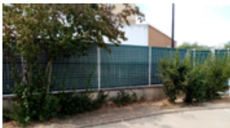
Installation de bandes occultantes au groupe scolaire Edith cavell
